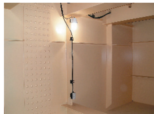
STEEL BOX 내부조명 설치
